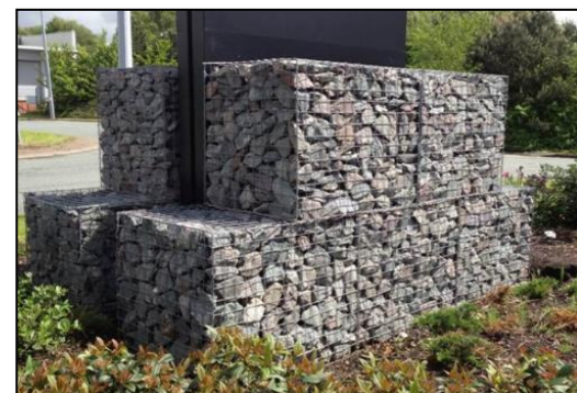
Figure 11 : Fixation par des gabions (Source : TCS Geotechnics)
