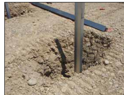
Figure 9 : Types de fondation - pieux battus
